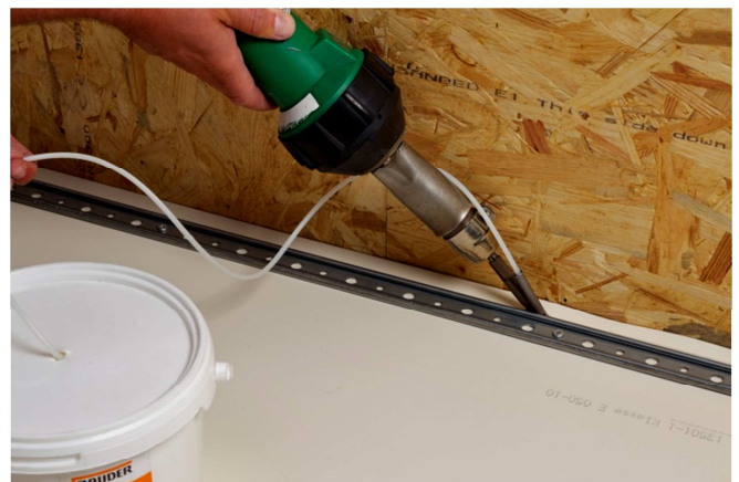
Verschweißung hinter der Befestigungsschiene
