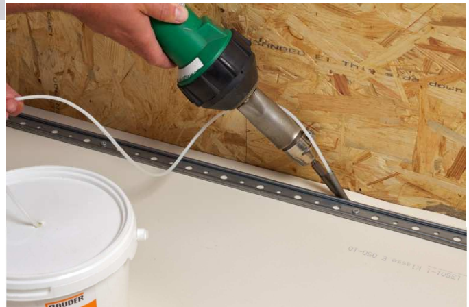
Verschweißung hinter der Befestigungsschiene
