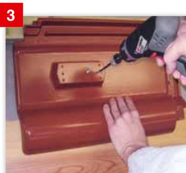
3 Die Alu-Solar-Trägerpfanne an den vorgezeichneten Stellen durchbohren  $\varnothing$  ca. 6 mm.
