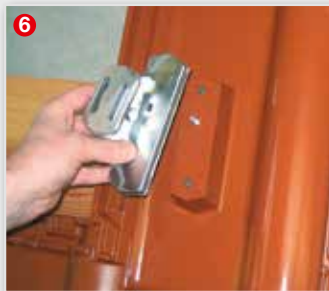
6 Jetzt kann der Solarträgersatz mit der Trägerpfanne verschraubt werden.
