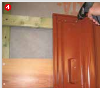
4 Die Alu-Solar-Trägerpfanne mit den beigefügten Edelstahlschrauben an der Traglatte befestigen.
