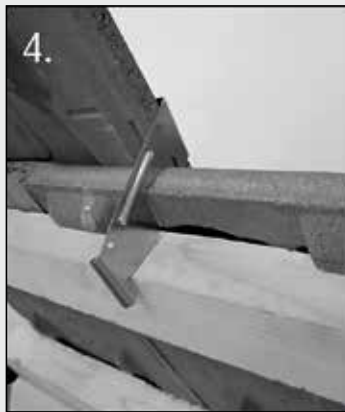
4. Klammer sitzt mit dem Ende hinter der Lattung. Fertig!
