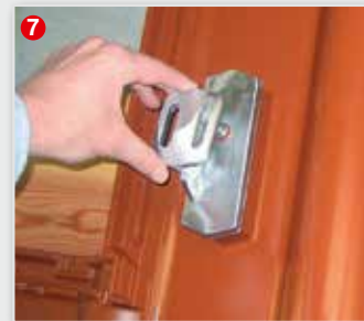
7 Anschließend den montierten Solarträgersatz nach Dachneigung ausrichten.
