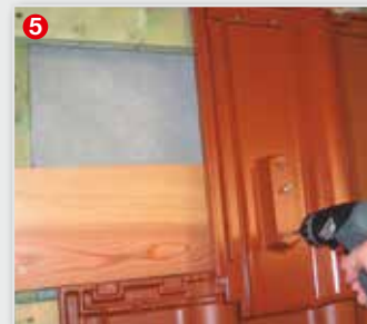
5 Die Alu-Solar-Trägerpfanne mit zwei Edelstahlschrauben in die Holzbohle befestigen. Die Länge der Schrauben ist bauseits zu bestimmen. Die Trägerpfanne hat keinen direkten Kontakt zur Holzbohle.
