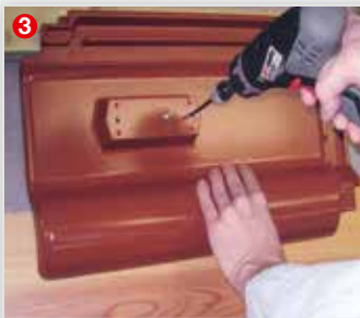
3 Die Alu-Solar-Trägerpfanne an den vorgezeichneten Stellen durchbohren ø ca. 6 mm.
