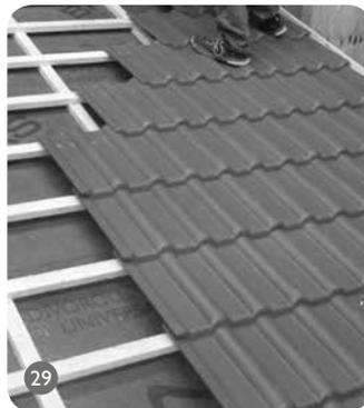
1. Pfannen stufenförmig versetzt verlegen, anschließend Pfannen klammern.
