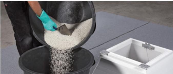
3. **Wichtig:** Anschließend umtopfen und nochmals mind. 1 Minute mischen, damit die Schüttung gleichmäßig mit dem Härter benetzt wird
