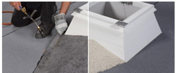
9. VILLAPERL ist nach ca. 1 Std. begehbar – nachfolgende Schichten müssen nach Aushärtung des Materials direkt aufgebracht werden
