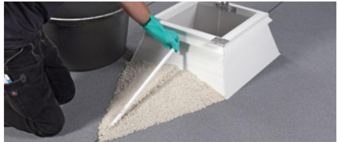
7. Richtlatte entfernen und mit VILLAPERL auffüllen
