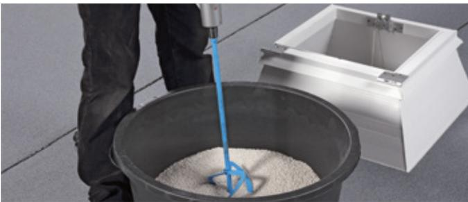
2. Mit einem langsam laufenden Rührwerk gut vermischen, Rührzeit mind. 2 Minuten
