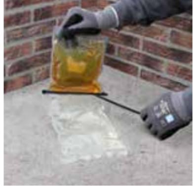
1. Öffnen Sie die Alu-Umverpackung an der Aufreißblase und entnehmen den Knetbeutel. Entfernen Sie die Gummischnur im Trennsteg des Zweikammerbeutels.
