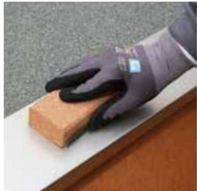
1. Die vorgereinigte Metallfläche von Hand mit Schleifpapier (Körnung P40-60) oder maschinell mit einer Fächerscheibe anschleifen. Anschließend den Schleifstaub entfernen.
