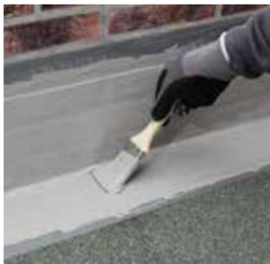
Nach dem Einlegen des Polyestervlieses in die noch frische 1. Lage wird die restliche Menge [1/2 bis 1/3] von **FRANKOSIL® 1K PLUS** auf die Fläche aufgetragen bis das Vlies eine getränkte glänzende Oberfläche hat. Anschließend sofort die Klebebänder entfernen.
