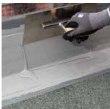
Verteilen Sie **FRANKOSIL® 1K PLUS** auf eine gleichmäßige Schichtstärke. Mindestens die Hälfte der geplanten Menge der Abdichtung (1/2 bis 2/3) wird in der 1. Lage aufgebracht.
