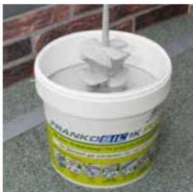
2. Öffnen Sie das Gebinde **FRANKOSIL® 1K PLUS** und rühren Sie den Inhalt mit einem Rührholz oder einem Korbrührwerk farbgleich auf.
