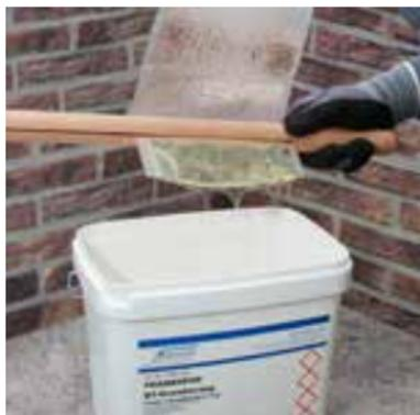
4. Streichen Sie das Material nach unten ab und schneiden Sie den Beutel auf. Entleeren Sie ihn mit einem Beutellentleerer.
