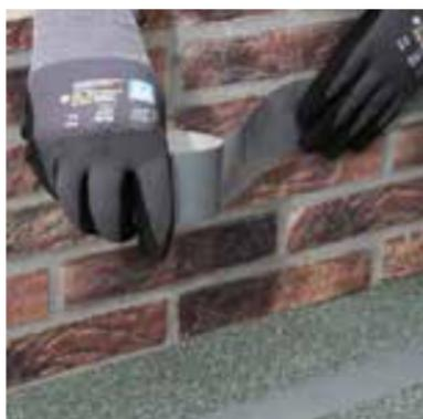
1. Schneiden Sie die Vliese passend nach Vorgabe zu und Kleben Sie die zu behandelnde Fläche sorgfältig ab. Dabei sollte das Klebeband 5 bis 10mm vom Vlies entfernt aufgebracht werden.
