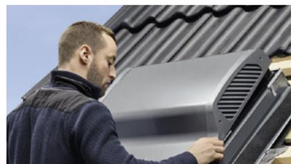
3. Die Abdeckung von VELUX Smart Ventilation wird aufgesetzt.
