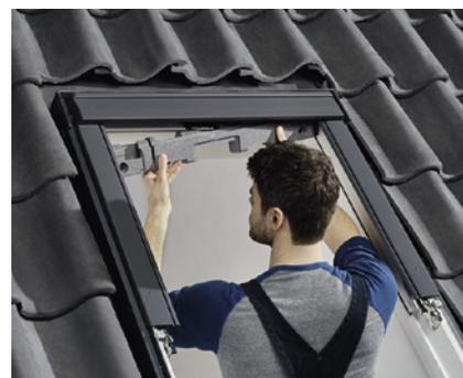
3. Anschließend den Dämmblock innen am Fenster gegen den im Lieferumfang enthaltenen austauschen.
