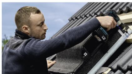
1. Anstelle des Markisenkastens wird VELUX Smart Ventilation einfach über das VELUX Dachfenster gesetzt – alles passt perfekt. Das Unterdach bleibt dabei unberührt.
