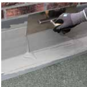
Verarbeitung mit Glättkelle
