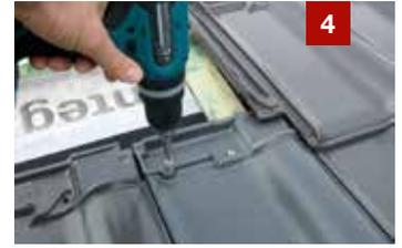
4 Alu-Grundplatte an der Traglatte mit den zwei Edelstahlschrauben befestigen.
