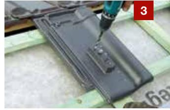
3 Universal-Halterung der Alu-Grundplatte an vorgegebenen Stellen vorbohren (6 mm).
