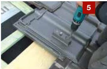
5 Alu-Grundplatte mit zwei Edelstahlschrauben in der Holzbohle befestigen.
