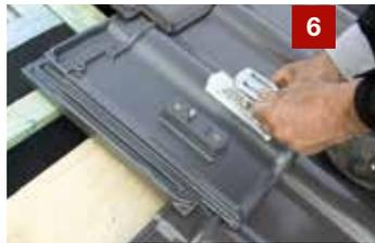
6 Solarträgeraufsatz auf der Alu-Grundplatte verschrauben.
