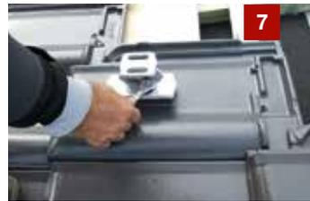
7 Solarträgeraufsatz auf die Alu-Grundplatte montieren und danach dachneigungsabhängig ausrichten.
