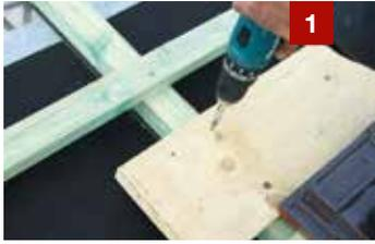
1 Holzbohle in Traglattenstärke (150 mm Breite) direkt oberhalb der Dachziegel durch die Konterlattung in die Sparren mit drei 6 x 100 mm Edelstahlschrauben befestigen.
