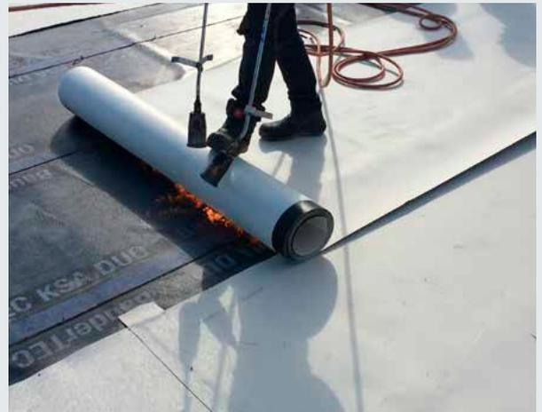
Zum An- bzw. Eindrücken der vlieskaschierten Bahn in die erwärmte Bitumenmasse kann ein Besen oder ein Wickelkern verwendet werden.
