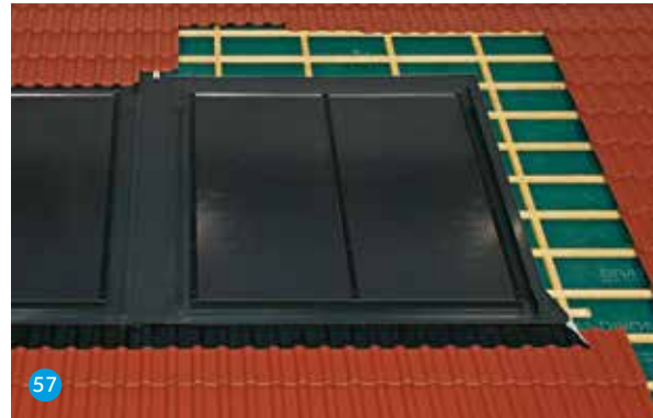
Beidecken des Kollektorfeldes
