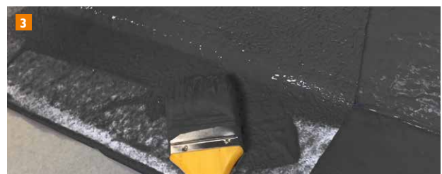
3 MOGAT LIQUID SOLO Vlies in die frische Einbettschicht einlegen, blasenfrei einarbeiten und ohne Warten das Vlies mit einer weiteren Schicht (Deckschicht) versehen.
