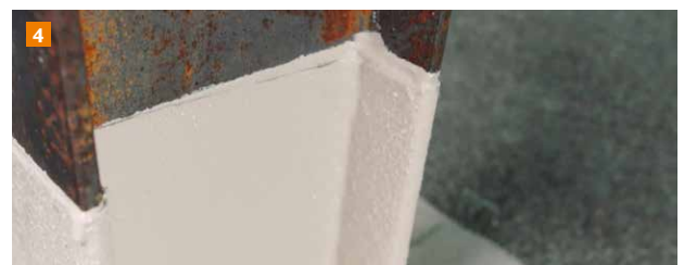
4 Nach Auftragen der Deckschicht wird das Klebeband entfernt, eine optische Anpassung ist anschließend möglich.
