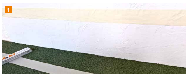
1 Lose Bestandteile und Verunreinigungen entfernen, Reinigen und Abkleben der Arbeitsfläche
