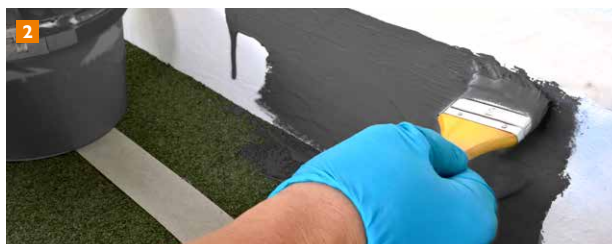
2 Vorlegen der Einbettschicht
