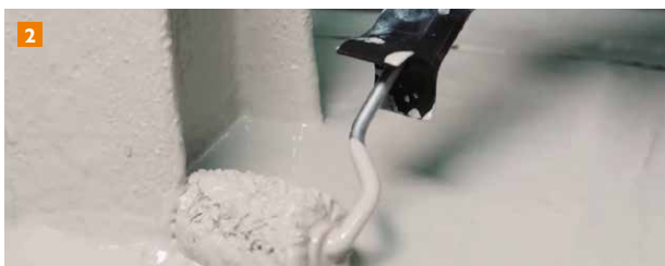
2 Auftragen der Deckschicht
