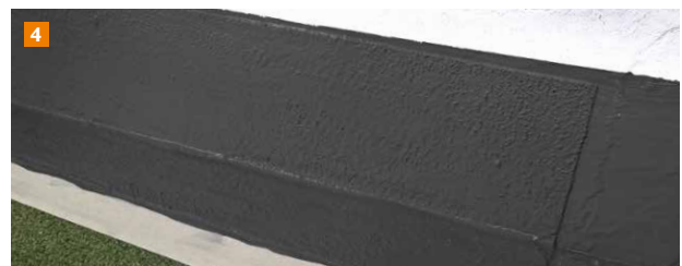
4 Nach Fertigstellung des Anschlusses, Klebeband im feuchten Zustand abziehen und ggf. zusätzliche Einstreuschicht aufbringen, falls eine andere Oberfläche (Schiefer etc.) benötigt wird.
