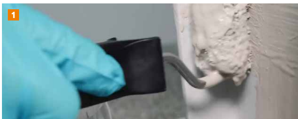
1 Nach Auftragen der Grundierung und Ansetzen von MOGAT LIQUID DA wird das Material vorgetragen.
