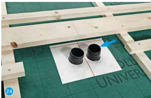
**Hinweis:** Die Durchführung der Anschlussrohre mit Isolierung wird erleichtert indem von unten die mitgelieferten Führungsrohre durchgedrückt werden. Nach der Verlegung des Kollektors werden diese von Innen durch Herausdrehen wieder entnommen. Damit wird gewährleistet, dass die Gummiabdichtung an der Rohrisolierung anliegt und der Durchgang luftdicht ist.
