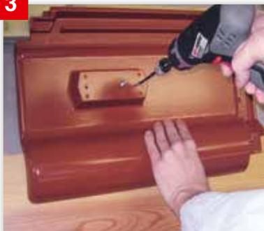
3 Die Alu-Solar-Trägerpfanne an den vorgezeichneten Stellen durchbohren  $\varnothing$  ca. 6 mm.
