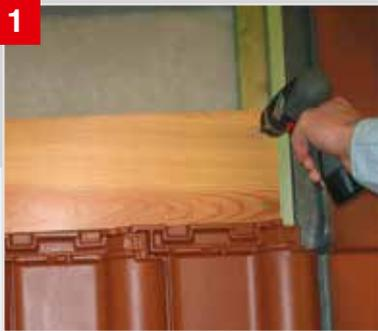
1 Holzbohle in Stärke der Traglatte (ca. 160 mm breit) direkt oberhalb der Dachziegel in die Konterlattung befestigen.
