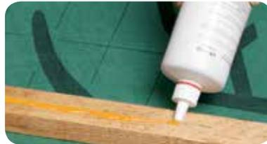
2. Divoroll Dichtmasse auf die Konterlatte auftragen.
