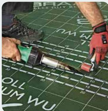
Sichere Verschweißung mit einem Heißluftföhn.
