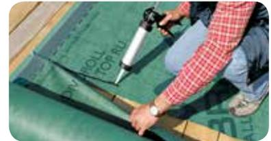
3. Verklebung von Querstößen und aufgehenden Bauteilen.
