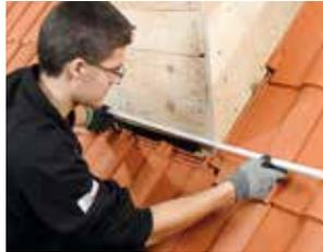
**4** Das Blech mittig fixieren. Durch Eindrücken des Bleches im Randbereich in Richtung der Dachneigung entsteht eine rechtwinklige Aufkantung.
