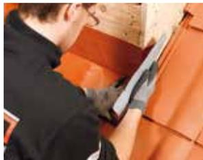
**5** Das Blech sorgfältig ausrichten. Die Schutzfolie abziehen und das Material andrücken. Das Blech mit Nägeln oder Schrauben zusätzlich fixieren.
