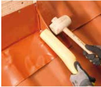
**11** Das obere Seitenblech ablängen. Das Maß ergibt sich aus der Länge der verbleibenden Dachpfannen plus eine Decksteinhöhe zuzüglich der Aufkantung im Kehlbereich von 150 mm.
